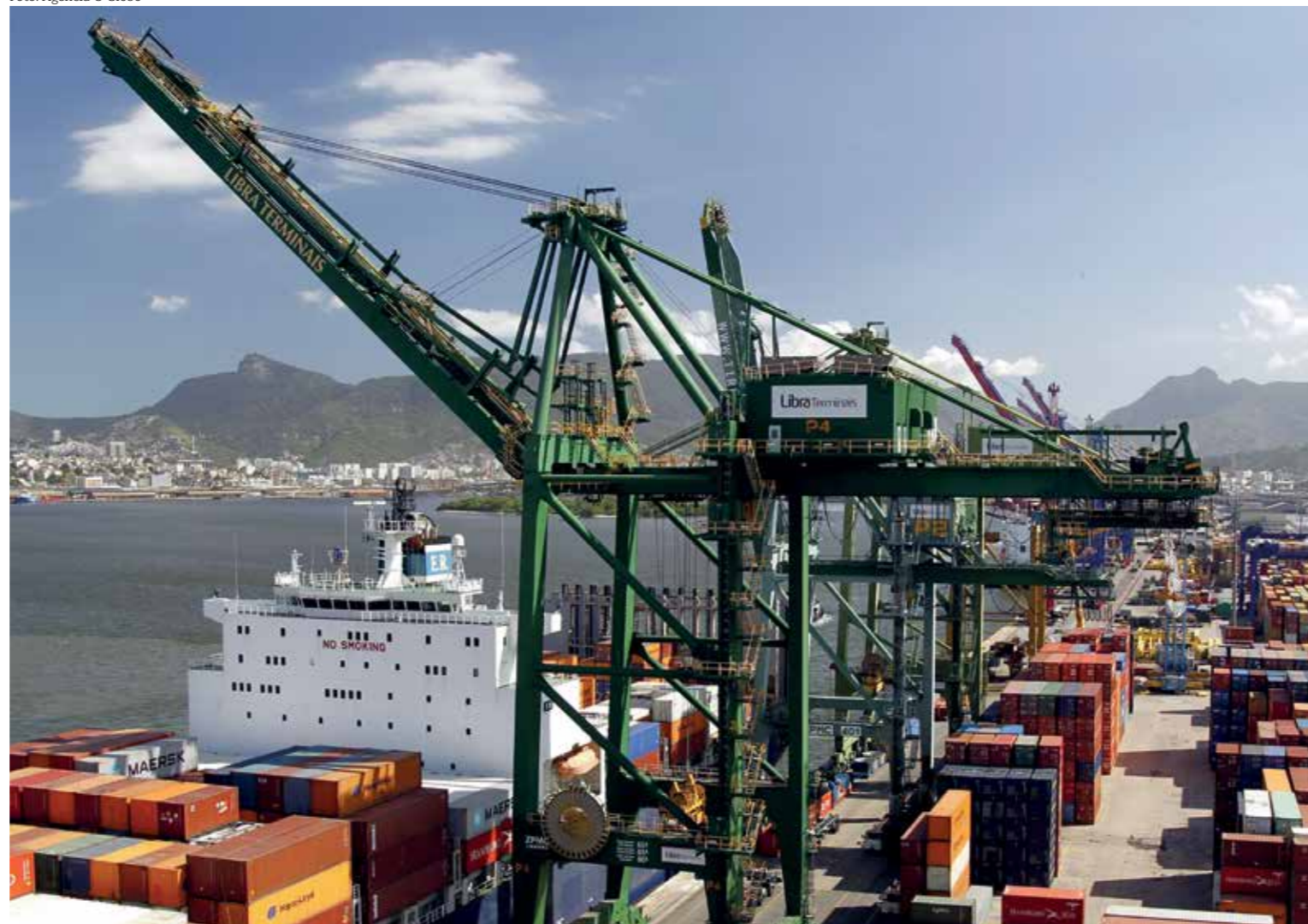
A precária infraestrutura dos portos: ponto crítico das exportações
